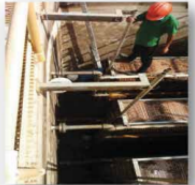
صيانة الاحواض الخاصة بمحطة الصرف الصحي والمعالجة
