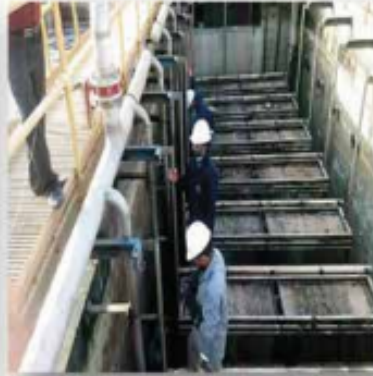
صيانة الاحواض الخاصة بمحطة الصرف الصحي والمعالجة
