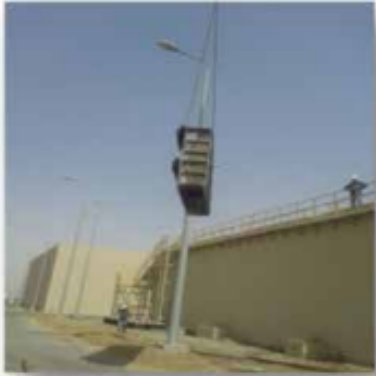
صيانة الاحواض الخاصة بمحطة الصرف الصحي والمعالجة
